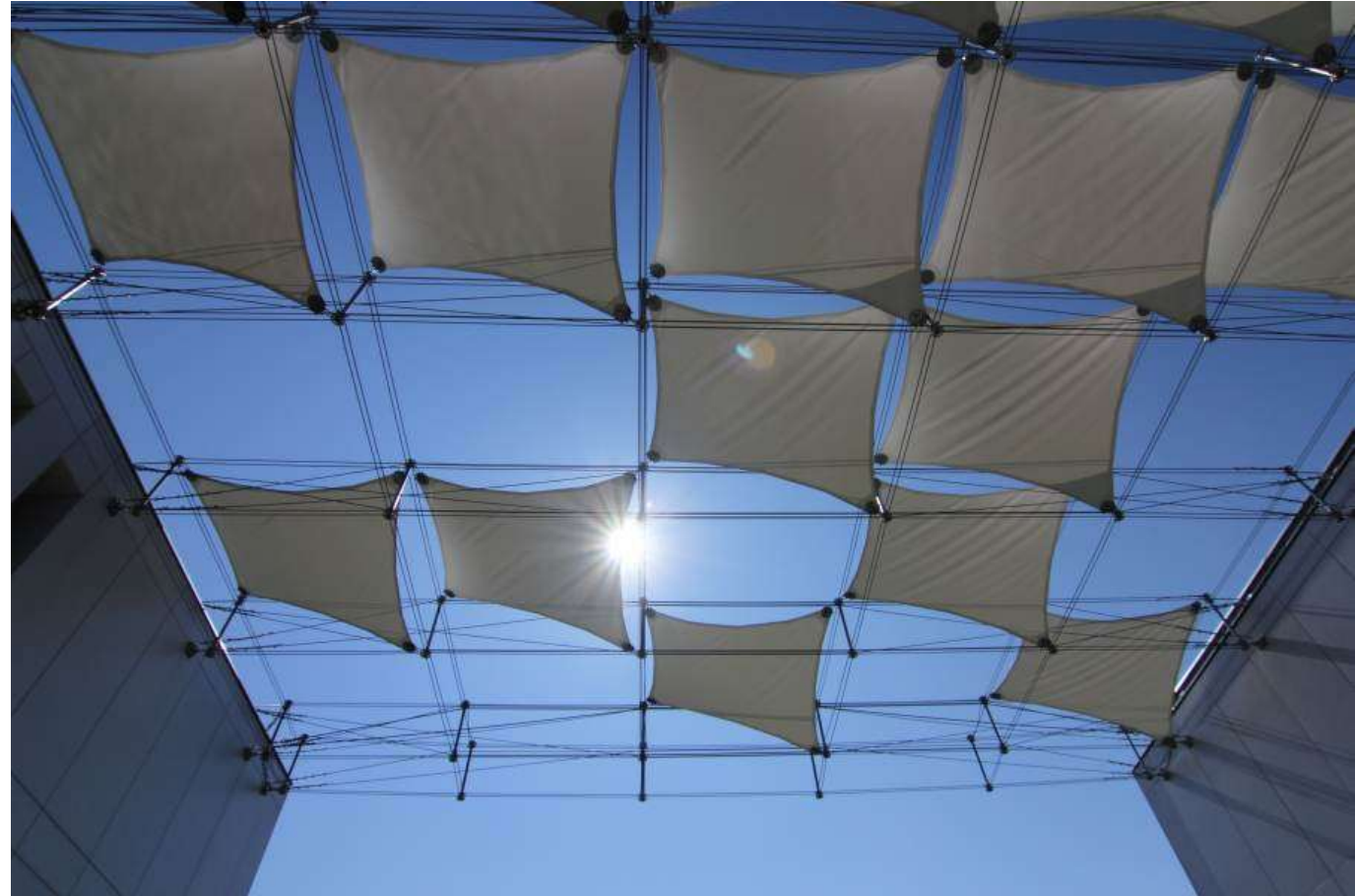
Szentendre, ÉMI irodaház Árnyékoló szerkezet Építész: Phul Antal DLA Statikus: Dr. Hegyi Dezső
